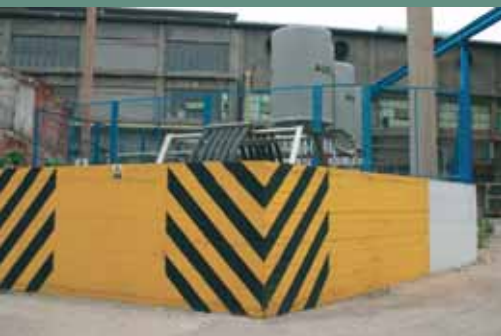
Θεμελίωση Ηλεκτρικής Καμίνου ΧΑΛΥΒΟΥΡΓΙΚΗΣ Ελευσίνα
