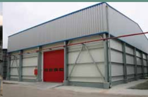
Κτήριο αποθήκης ΙΟΝ (Clean Room) Αρτα
