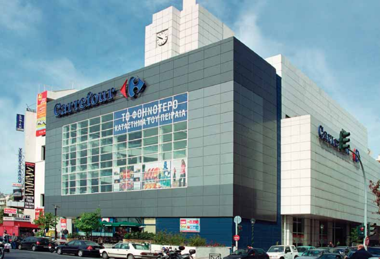
Επέκταση & Ανακαίνιση καταστήματος CARREFOUR Πασαλιμάνι
